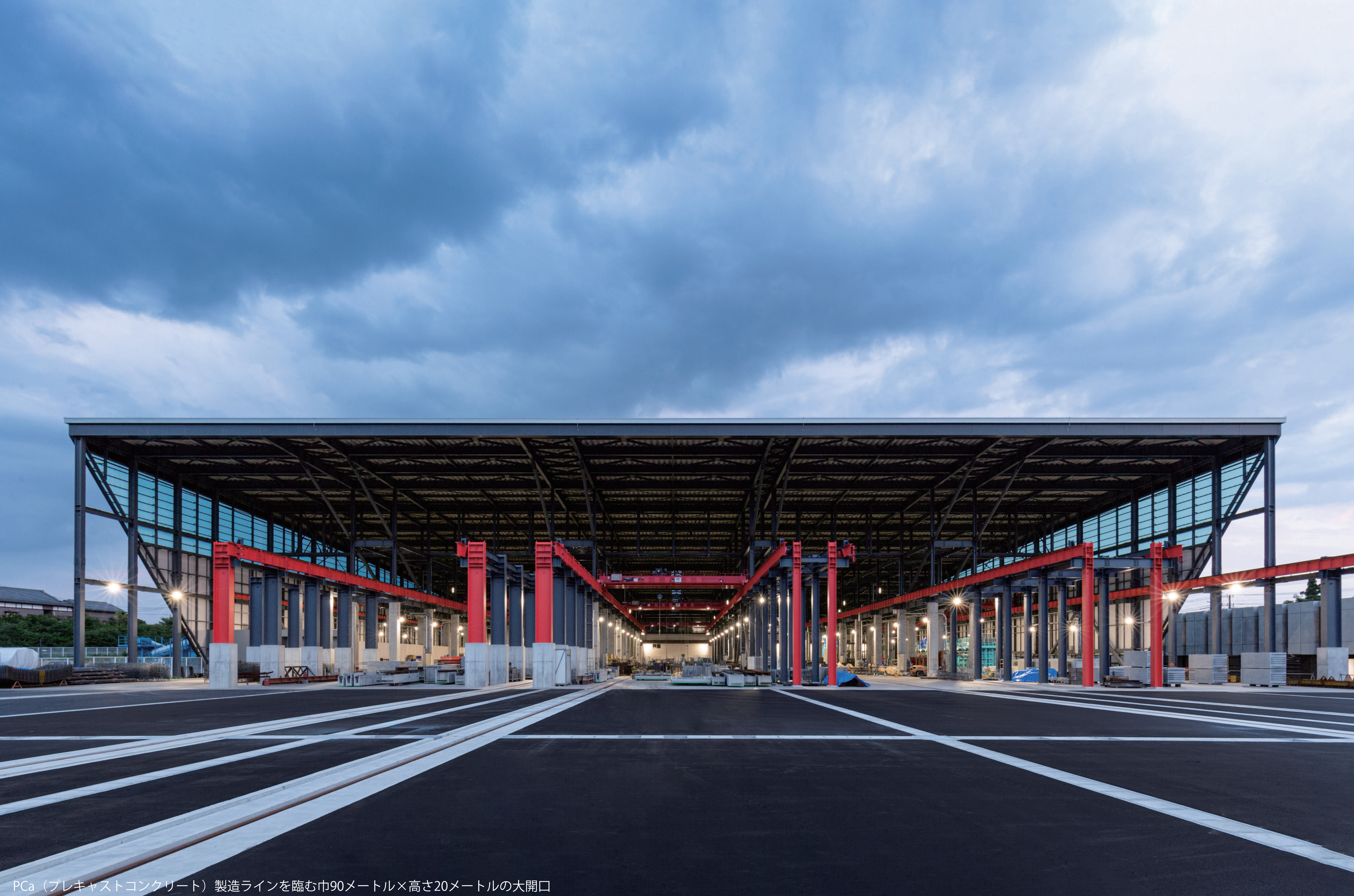
PCa（プレキャストコンクリート）製造ラインを臨む巾90メートル×高さ20メートルの大開口
