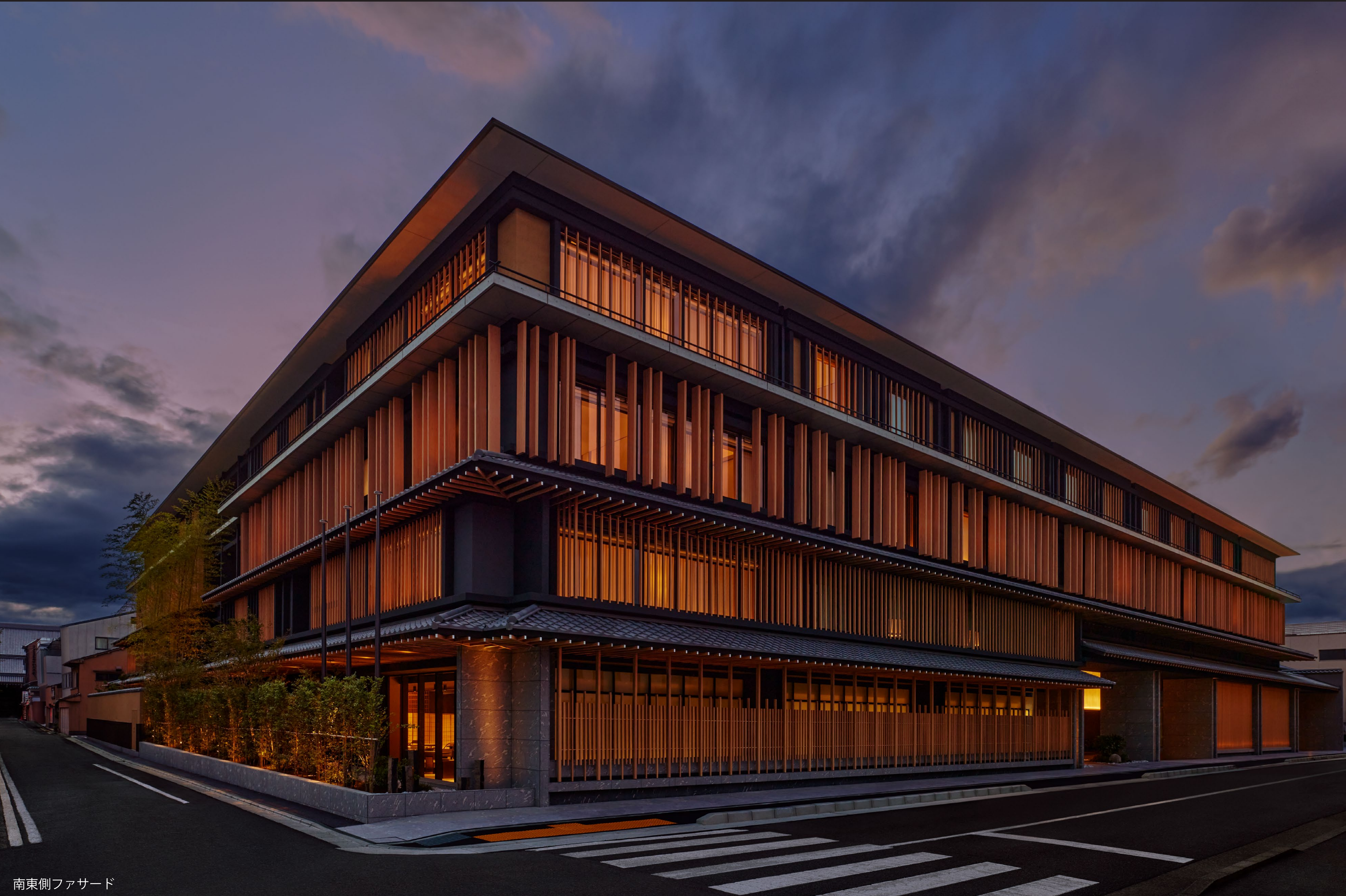
南東側ファサード
